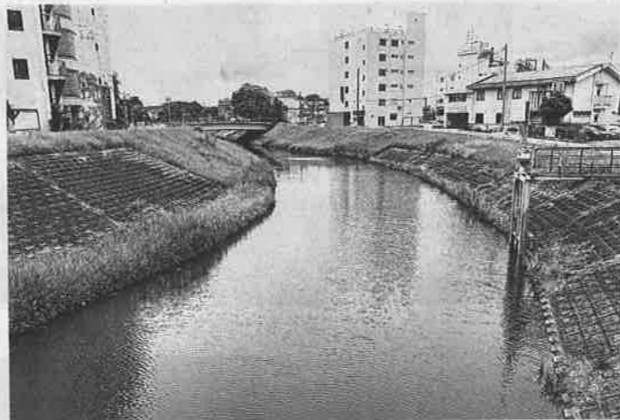
掘削工や盛土工などを実施する逆川(水戸市)
