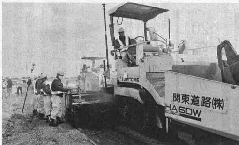
ファイニッシャーを使ったICT施工
