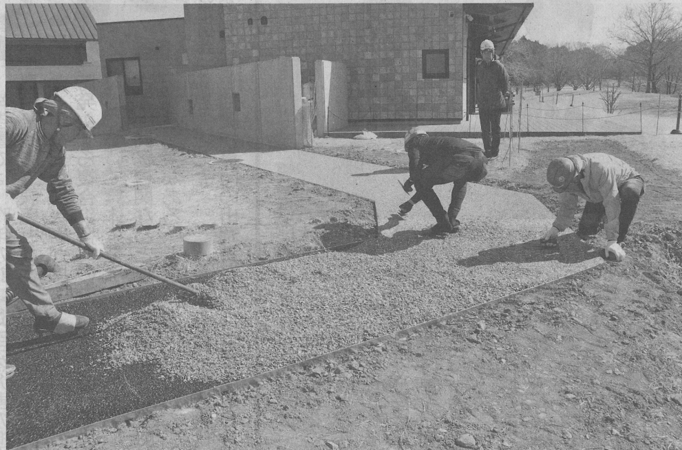
陶器片は不ぞろいのため、舗装作業は手作業で丁寧に行われる。いずれも笠間市笠間
