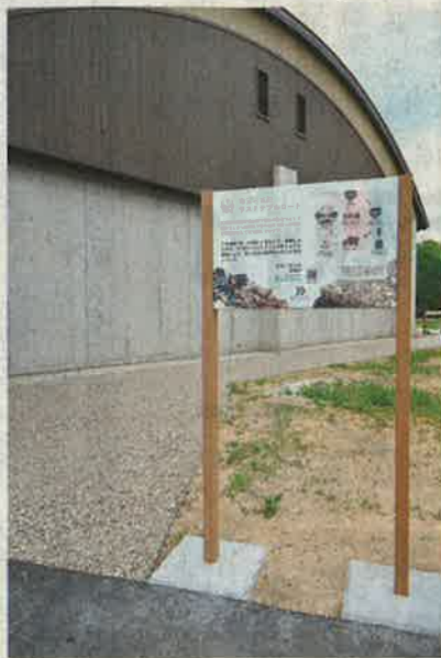
笠間焼廃材を利活用した遊歩道と周知看板＝笠間市笠間
